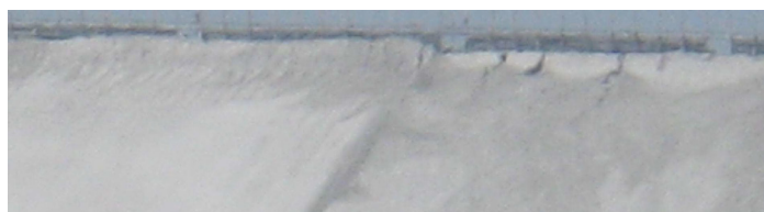
Figura 3b, ampliación de parte superior de la fractura con hundimiento de parte del muro, que se observan en la Figura 3a.
